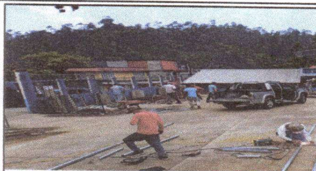
Foto 2: Maestro de Obra y albañiles trabajando según planificación del arquitecto Tito Juárez.
