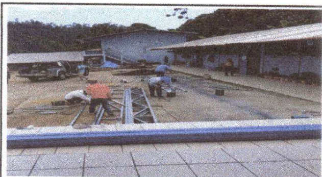
Foto 3: Personal trabajando en herrería, armando los YOIS, soldando costaneras, e iniciando a pintar las mismas.
