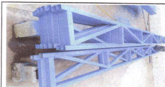
Foto 4: Se puede observar y apreciar el armado y pintado de los YOIS que servirán de fuerza y unión entre las costaneras.
