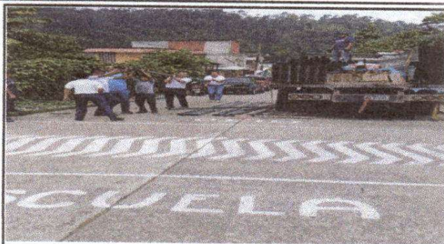
Foto 1: Descargando el material que servirá para la Estructura del techado del patio de la escuela.
