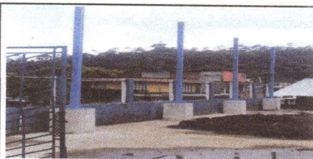
Foto 5: Colocación de platinas que sostienen las costaneras sobre las columnas de concreto del ala sur de la escuela.
